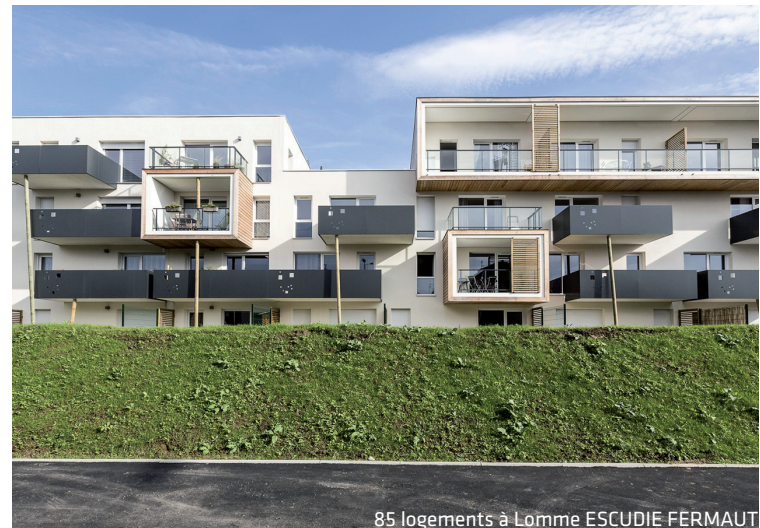
85 logements à Lomme ESCUDIE FERMAUT
