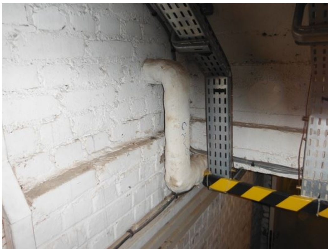
Calorifugeage plâtre + laine Dgt 1
