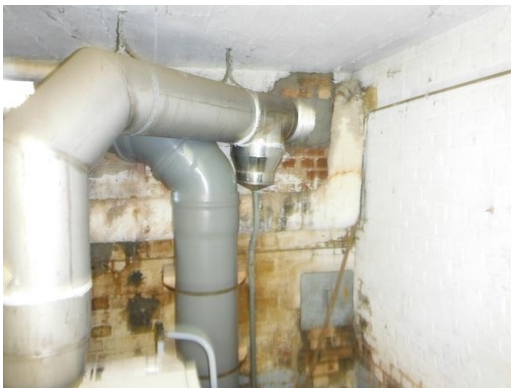
Calorifugeage plâtre + laine Chaufferie
