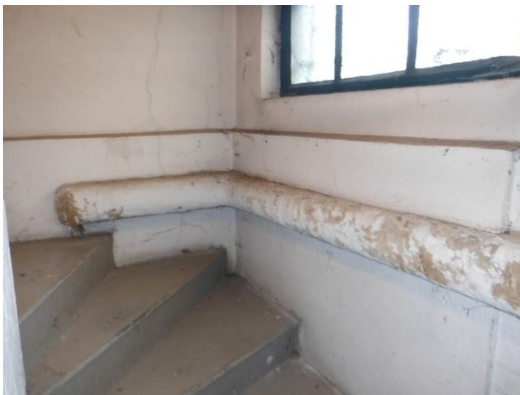
Calorifugeage plâtre + laine Dgt 1
