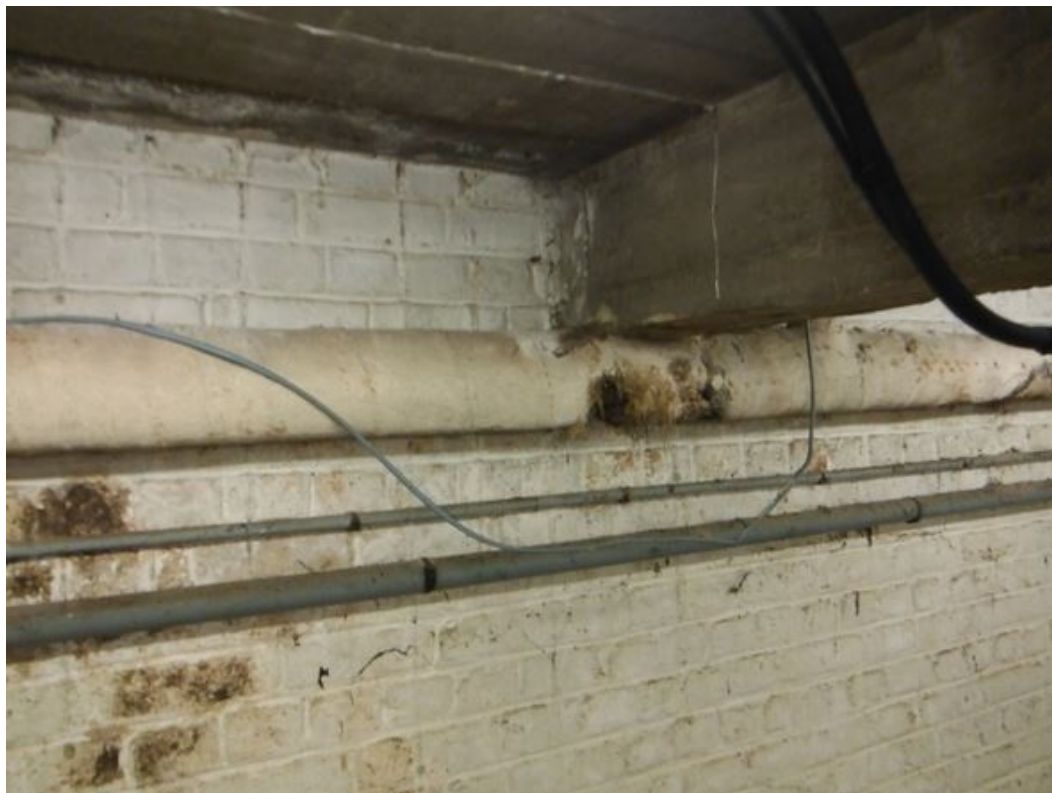
Calorifugeage plâtre + laine Archives 3
