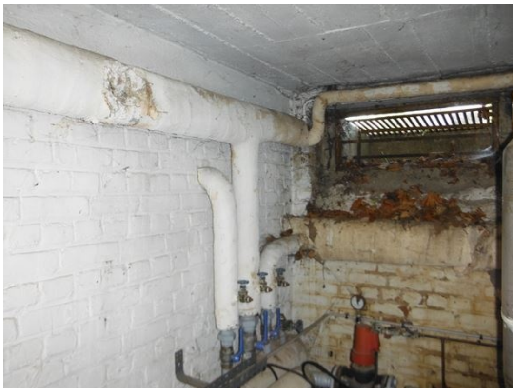
Calorifugeage plâtre + laine Chauffage
