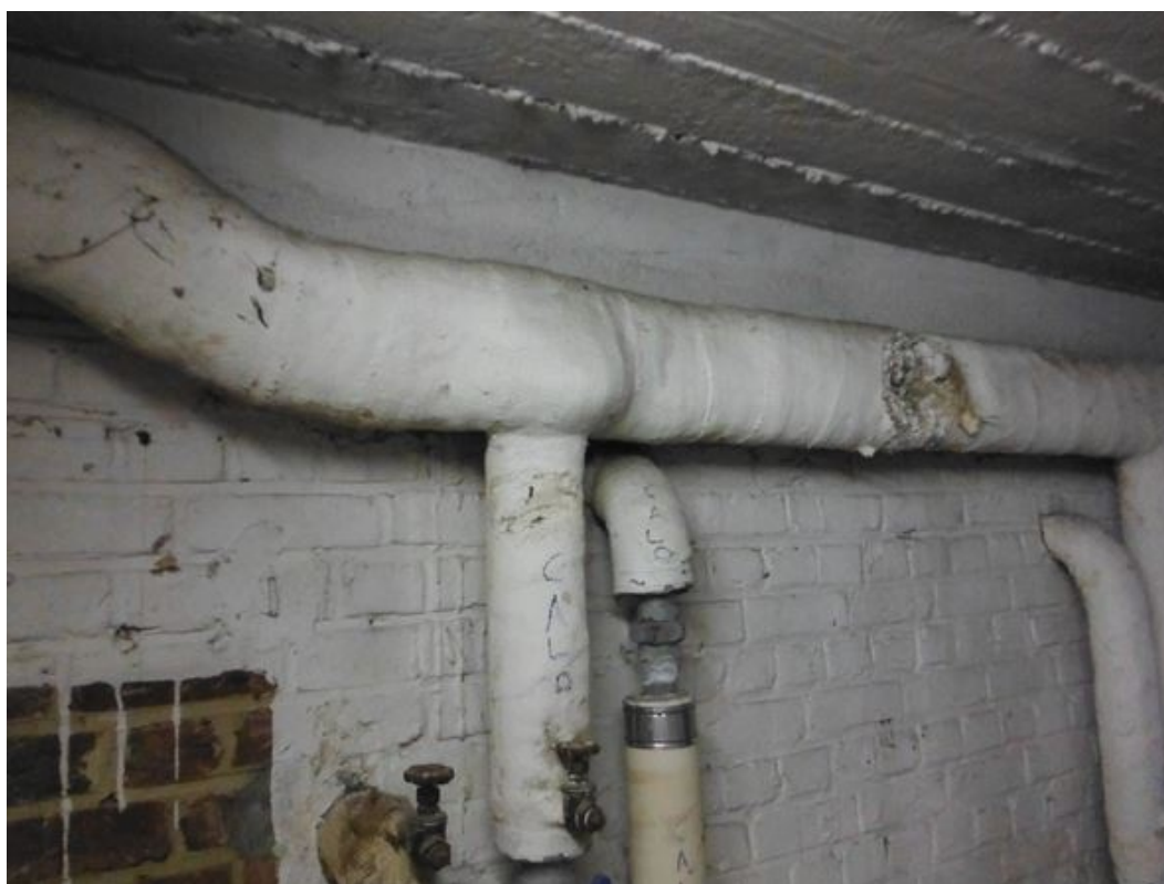
Calorifugeage plâtre + laine Chauffage
