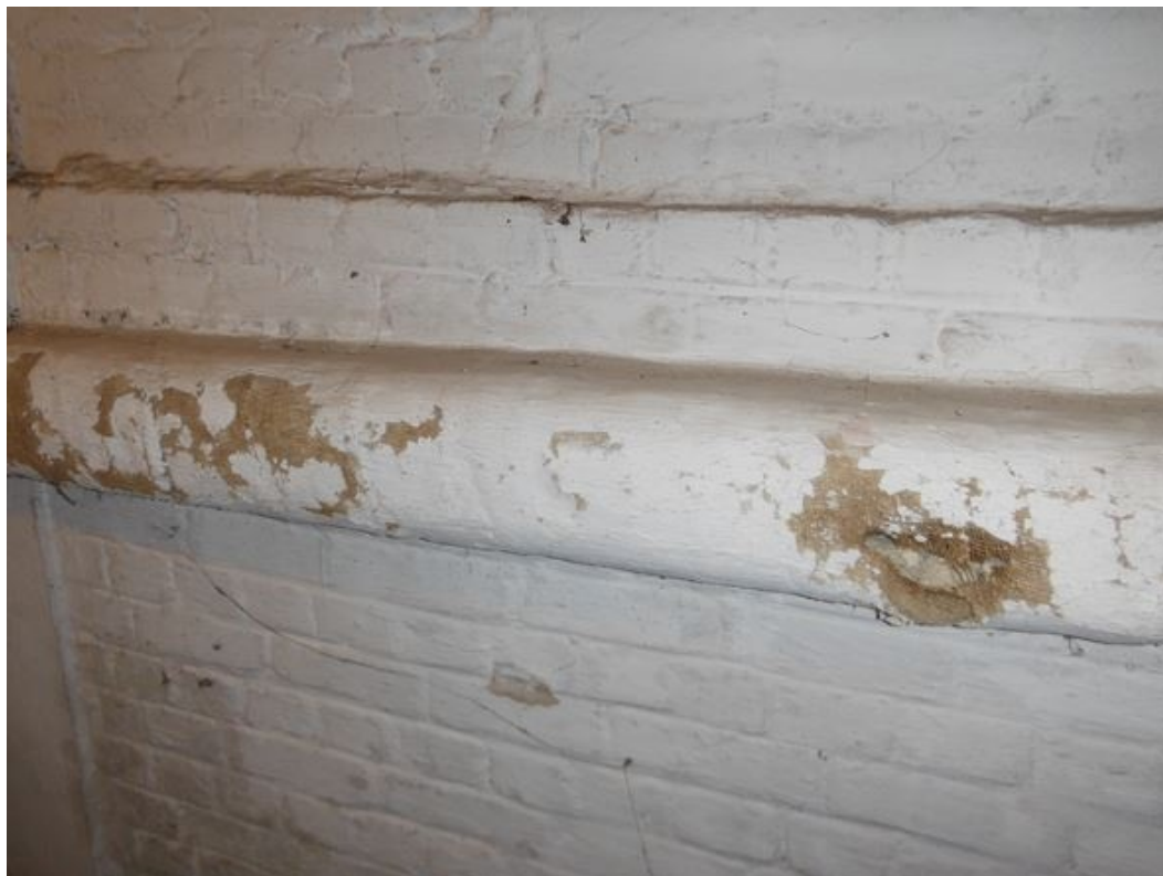
Calorifugeage plâtre + laine Dgt 1
